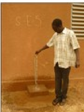
Par gravitation, l'eau est distribuée dans 9 lavabos et robinets répartis dans les 3 bâtiments du CSPS, et rejetée dans des puisards couverts.
