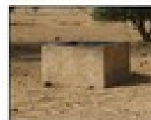
Construction d'un incinérateur pour déchets
