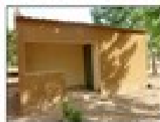
Construction de cuisines pour les accompagnants
