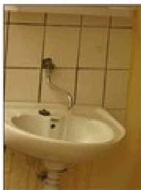
Par gravitation, l'eau est distribuée dans 9 lavabos et robinets répartis dans les 3 bâtiments du CSPS, et rejetée dans des puisards couverts.
